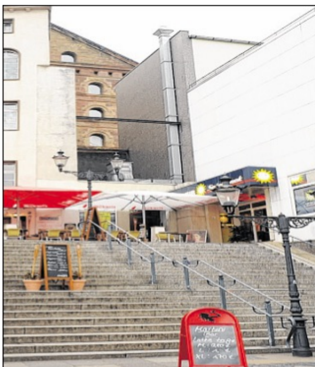
Die IHK begrüßt die Idee, an der Martinitreppe einen öffentlichen Fahrstuhl zu installieren. MT-Archivfoto: Otto
