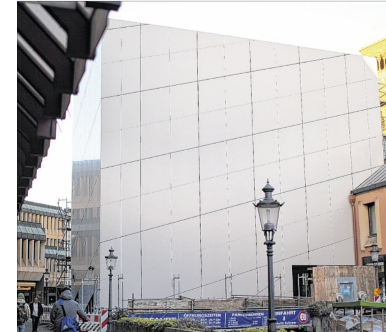
Auf der Rückseite zur Domstraße ist die Fassade der neuen Domschatzkammer bereits fertiggestellt. Ende März soll die neue Ausstellung eröffnet werden. MT-Foto: Alex Lehn
